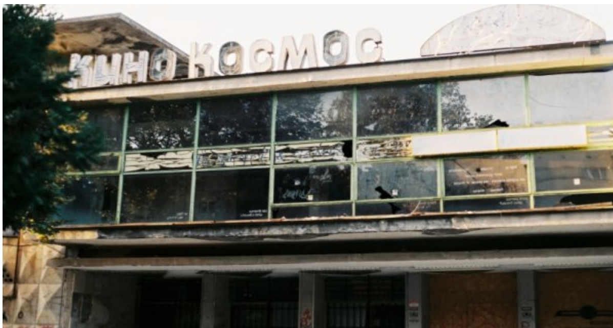
La façade du Kosmos en octobre 2018
