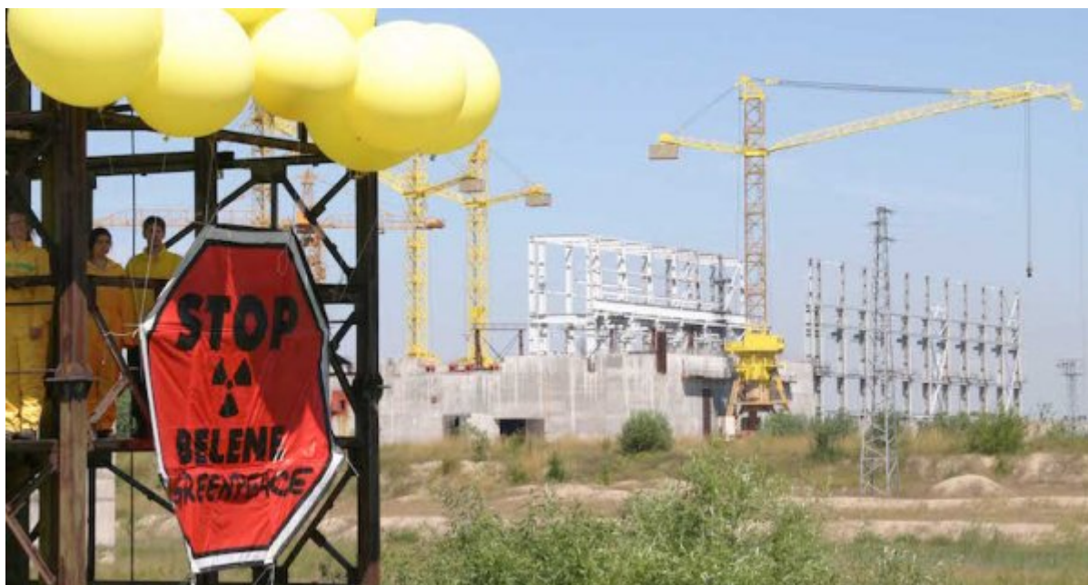
Les militants de Greepeace contre la construction de Belene
